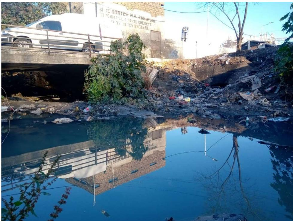
15 La imagen nos muestra la cantidad de residuos que se acumulan en la zona por debajo del puente de la calle Heredia, también se puede observar obstrucciones en las descargas de los pluviales laterales.
