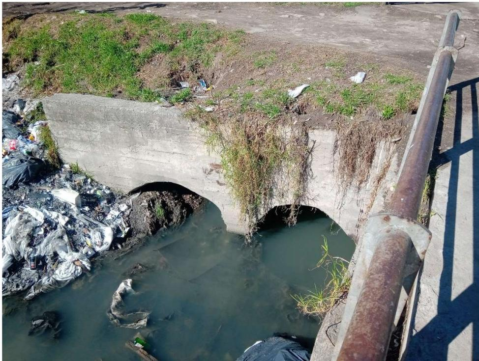
18 En la imagen pueden observarse las descargas de pluviales laterales. Fuente: Elaboración Propia
